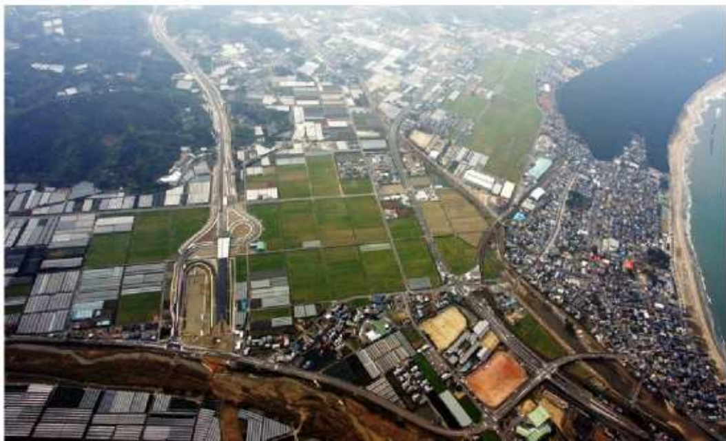
西九州自動車道 浜玉 IC 全景
