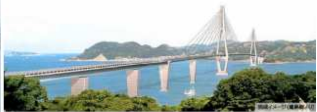
鷹島肥前大橋完成イメージ（鷹島側より）
