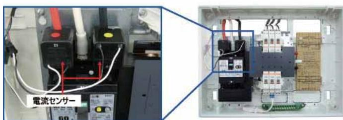
※電流センサー取り付け例（左図）
