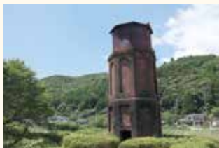
厳木駅にある給水塔
