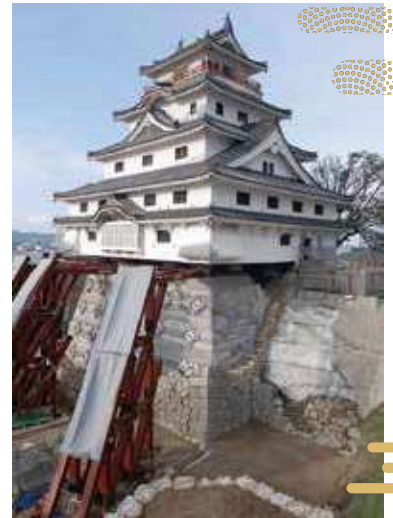
石垣解体修理時の唐津城跡天守台
