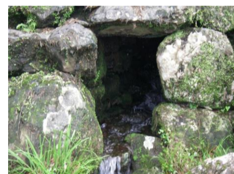
蕨野棚田の暗渠 すぐに水を引き込むと冷たい為、田の周りを一周してから田へ水を引き込む工夫がなされている
