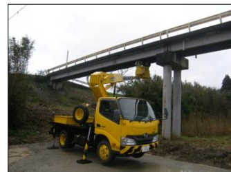
高所作業車による点検状況
