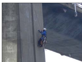
特殊高所技術による点検状況
