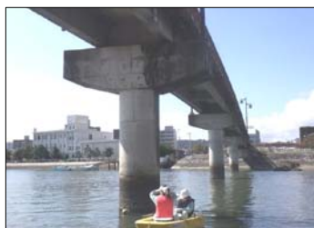
ボートによる点検状況
