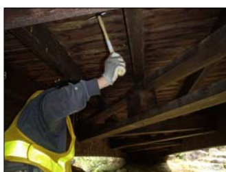
木橋の点検状況
