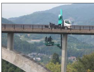
橋梁点検車による点検状況
