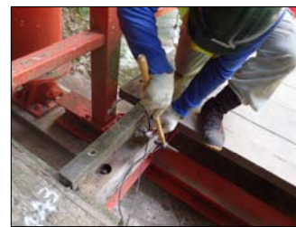
木橋の腐食度調査
