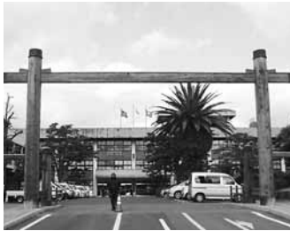
唐津市役所本庁舎
