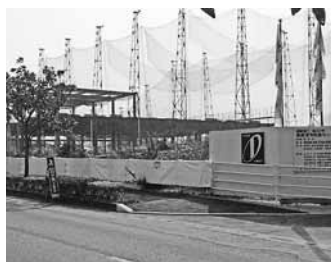
給食センター建設現場
