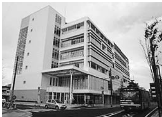
市民交流プラザが入居する大手口センタービル
