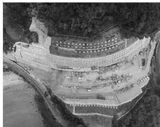
国道204号線湊工区の工事風景
