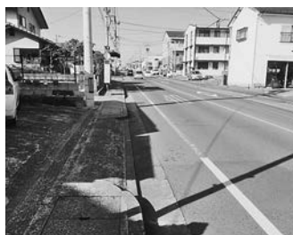
市道・東町和多田線の歩道
