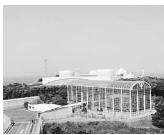
原子力発電所
