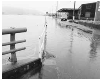
浜崎駅南側浸水状況
