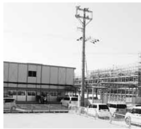
改築工事がすすむ鏡山小学校とプレハブ校舎
