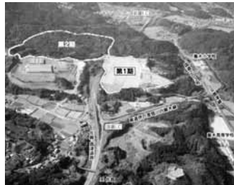
厳木工業団地
