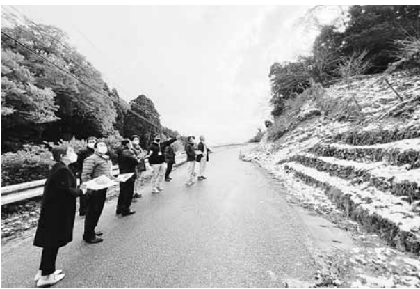
市道狩川うそ五反田線道路災害（七山）
