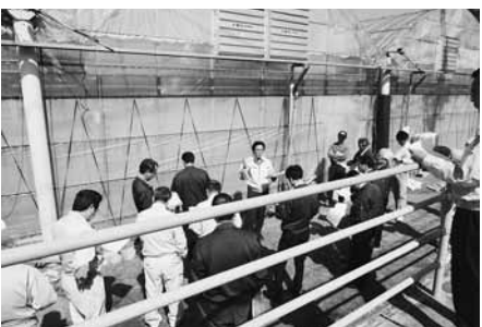
高機能ハウスの整備
