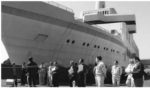
唐津浄水センター
