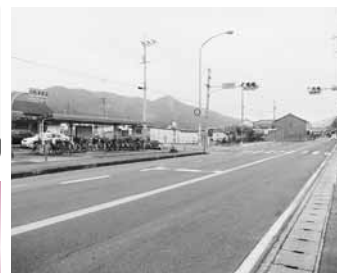
歩道整備が進む山本駅周辺
