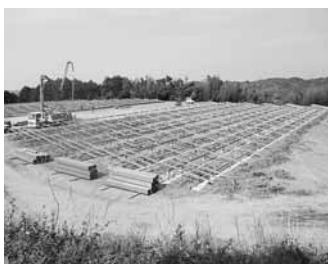
建設中のメガソーラー
