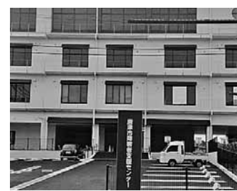
唐津市障害者支援センター予定地
