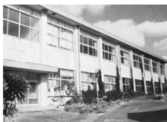
解体予定の神集島中学校
