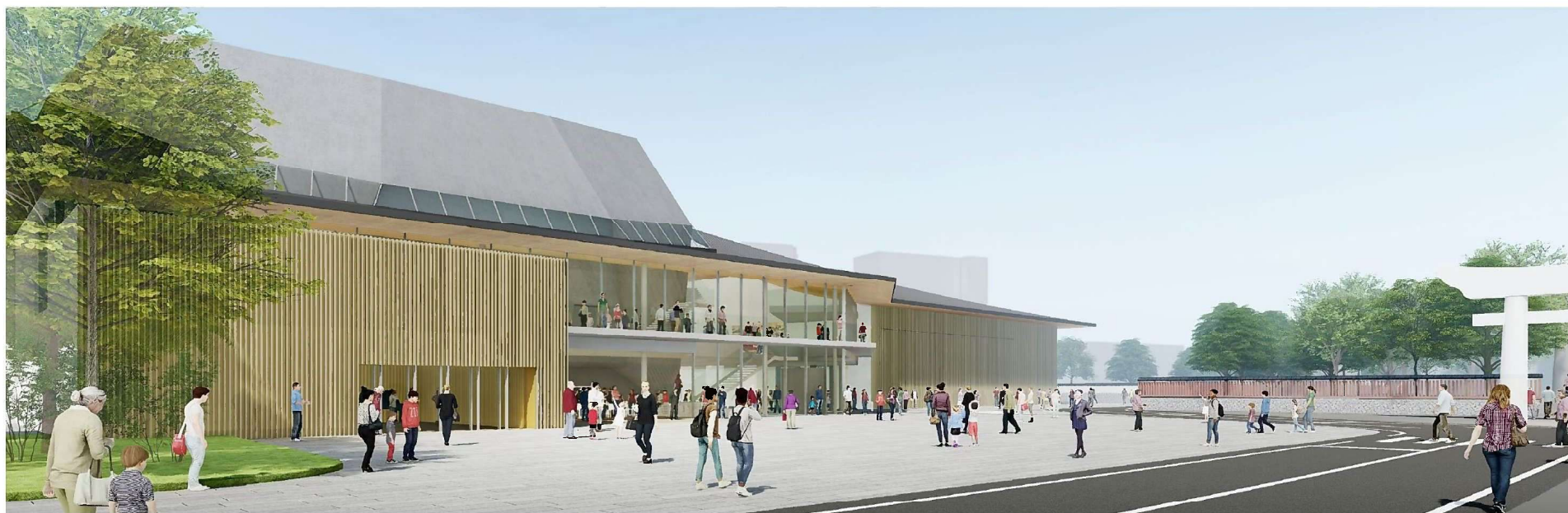
施設南東側より
