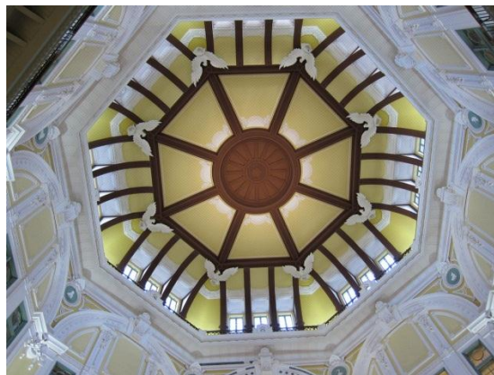
東京駅 北口ドームの天井部
