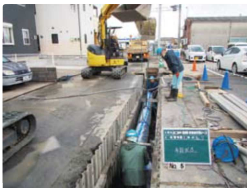
老朽化した水道管の更新
