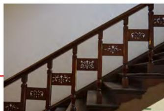
すかし模様は、よく見ると少しずつ模様が変わります。設計段階で実寸代の図面をつくり製作されています。
