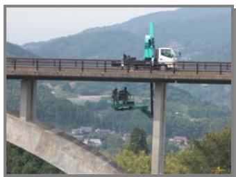
写真9 橋梁点検車による点検状況
