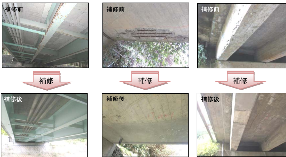
写真3 鋼桁の腐食
