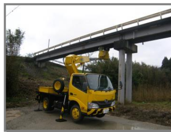
写真11 高所作業車による点検状況
