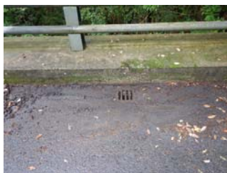
写真8 排水柵の清掃後
