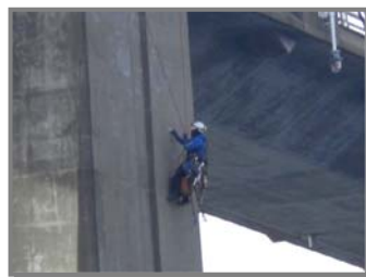
写真10 特殊高所技術による点検状況
