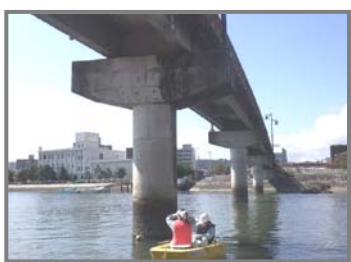
写真12 ボートによる点検状況
