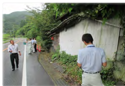
危険度判定のための現地調査
