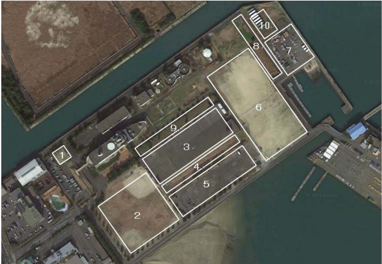
図-2.1 太陽光発電設備を設置する候補地
