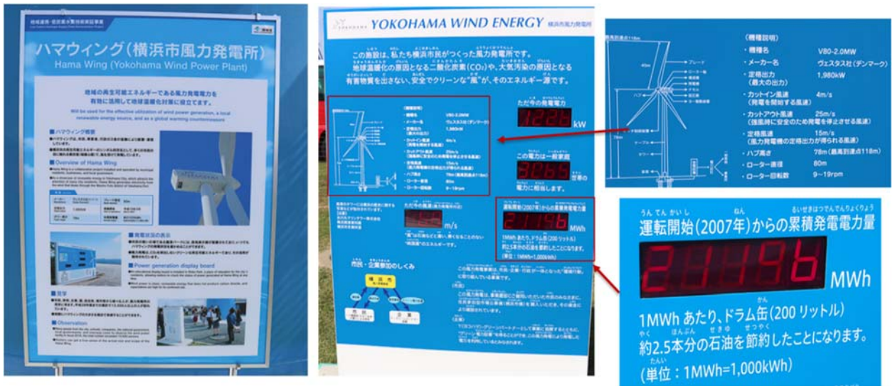
図-1. 6 5 横浜市ハマウィングの風力発電施設概要とパネル事例 6
