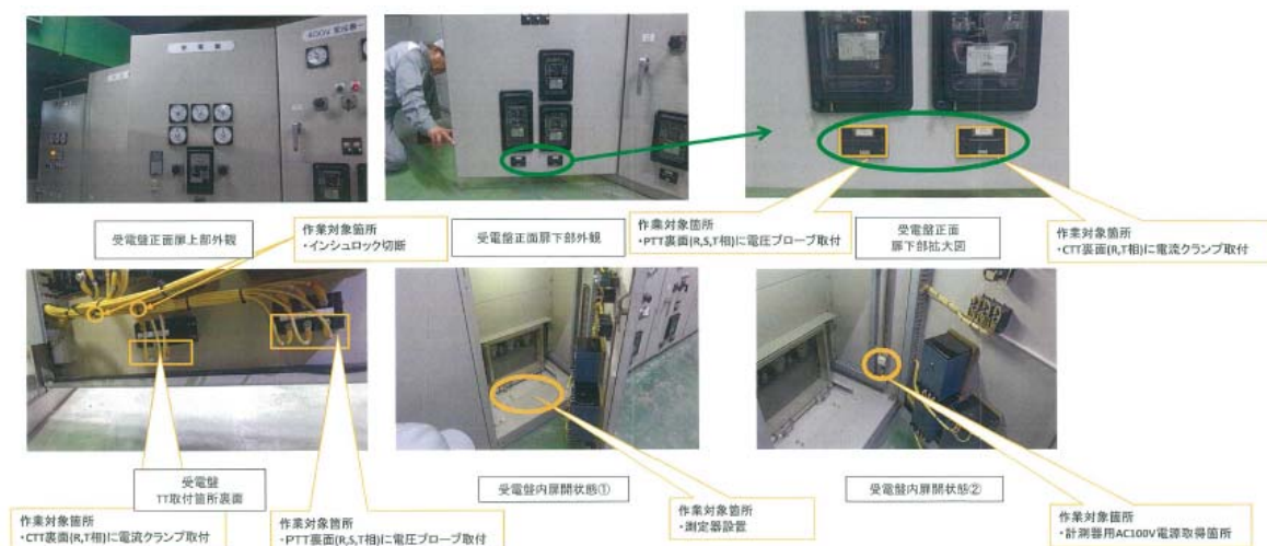
図-1. 28 浄水センターへの仮設計器取り付け方法
