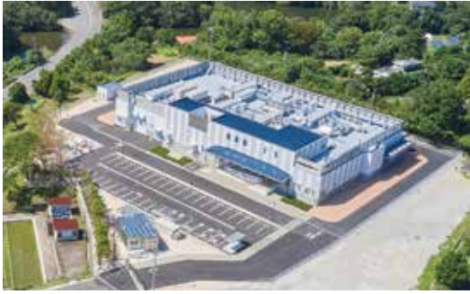
↑西部学校給食センター竣工後(令和5年9月)
