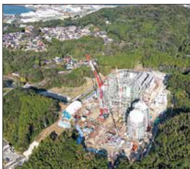
〈建設中のバイオマス発電所〉 （出所：合同会社唐津バイオマスエナジー）
