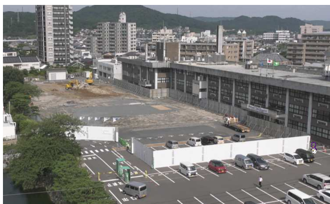
撤去工事の様子
