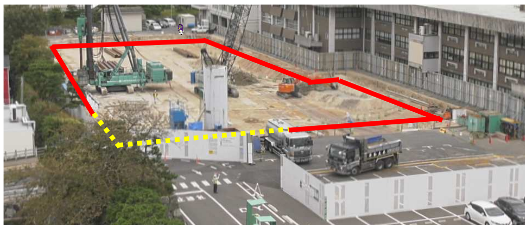
R2.10.13現在 土留連壁設置工事
