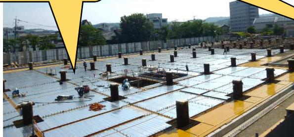
デッキプレートのうえに鉄筋を組み上げています
