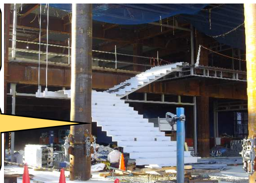
柱や梁の鉄骨が耐火被覆された様子
