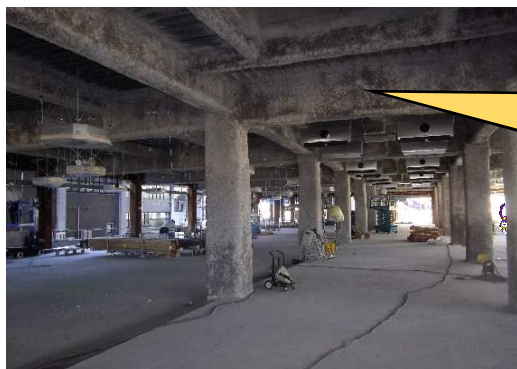
柱や梁の鉄骨が耐火被覆された様子
