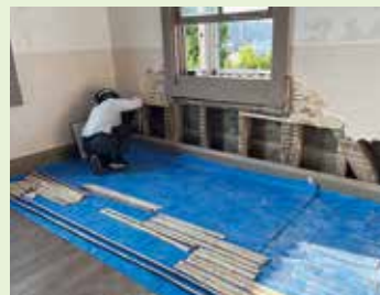
▲修理工事に向けた事前調査
