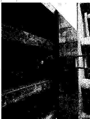
剥離鉄筋露出状況
