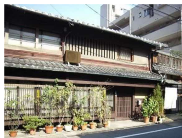
屋根の上にある室外機も茶色に着色して目立たせない
