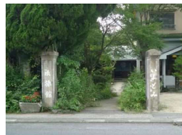
石柱の門に看板の機能を持たせたデザイン
