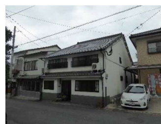
前面道路に対して平入りの切妻で瓦屋根の建物
