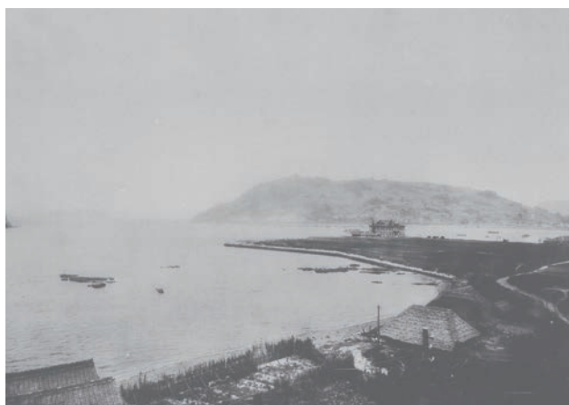
建設当時の旧三菱合資会社唐津支店本館 【国立国会図書館ウェブサイトより】
