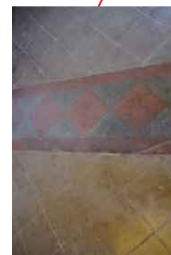
瓷砖？石？ 其实它是大理石粉末与水泥混合 后抛光加工形成的水磨石地板。
