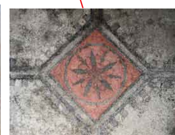
瓷砖？石？ 其实它是大理石粉末与水泥混合 后抛光加工形成的水磨石地板。
