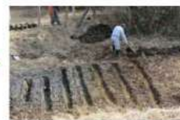
土砂堆積部分の浚渫
