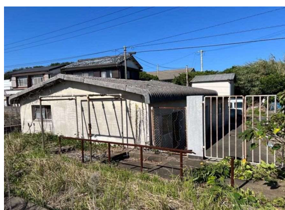
プール更衣室及び便所
