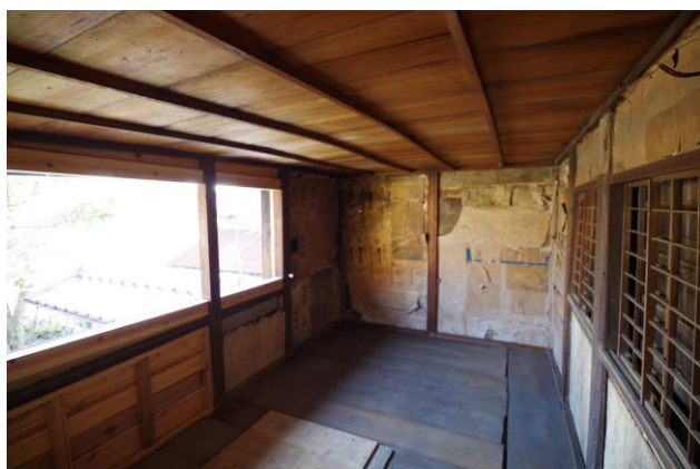
2階月見部屋 内部（北西より見る）
