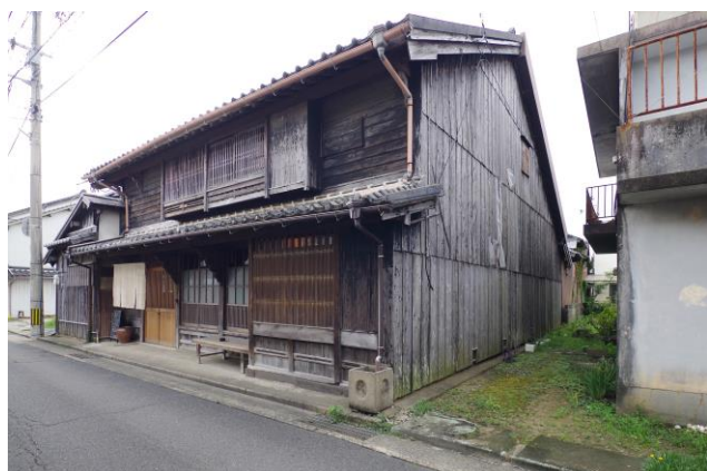
主屋 外観（北西より見る）
