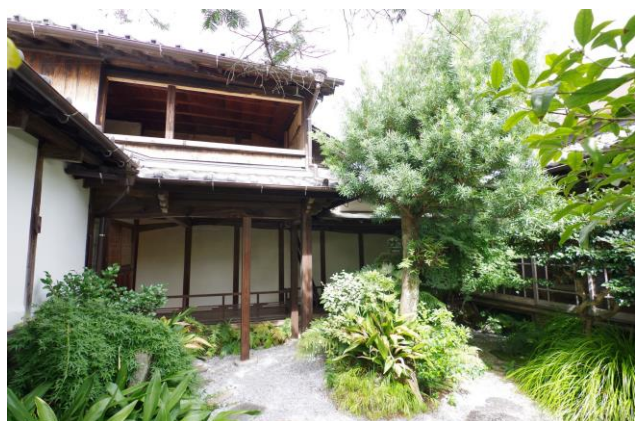
便所兼月見部屋 東面外観
