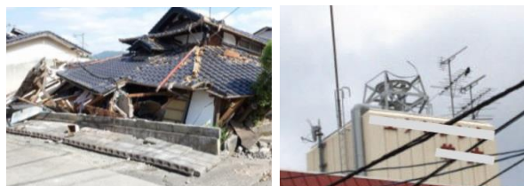
図：ブロック塀・屋上突出物の被害 (写真：国土交通省国土技術政策総合研究所)
