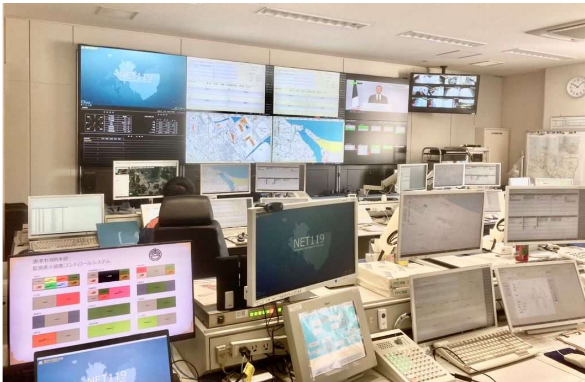
消防指令センター
