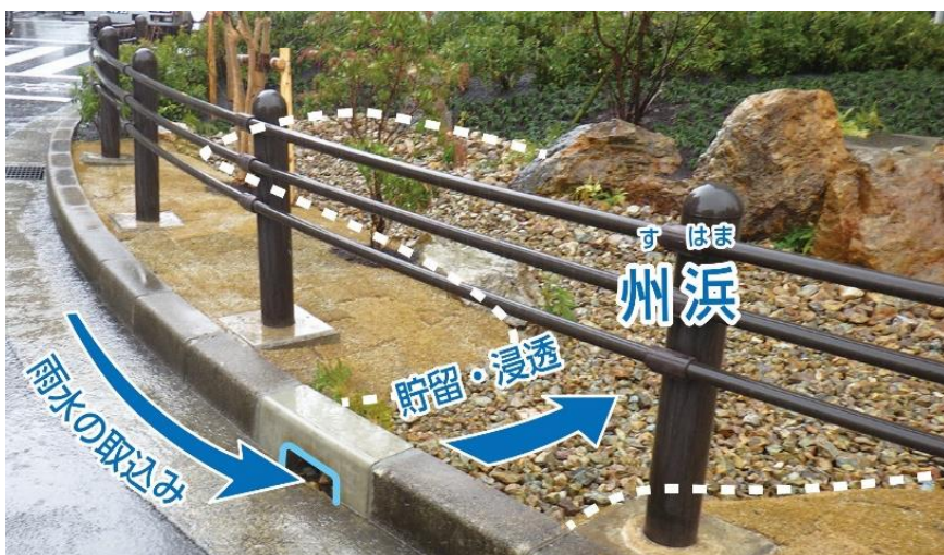
路面の雨水を透水性の州浜に導水し一時貯留浸透させる
