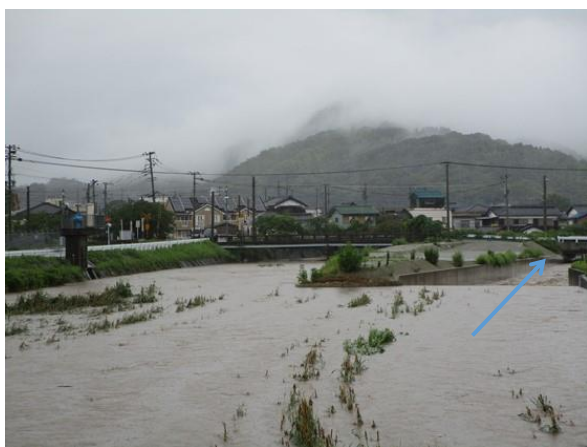
河川改修(分水路)
