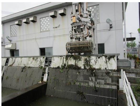
排水ポンプの運転
