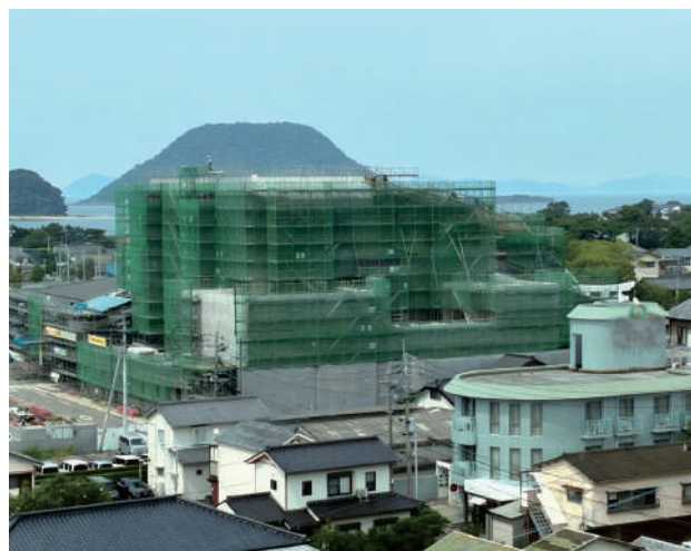
新唐津市民会館（仮称）の建設状況
