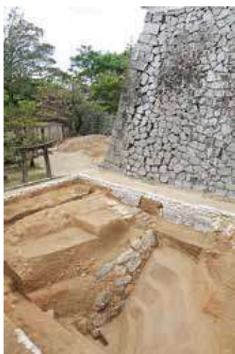
地中に埋没した旧石垣
