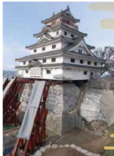
石垣解体修理時の唐津城跡天守台
