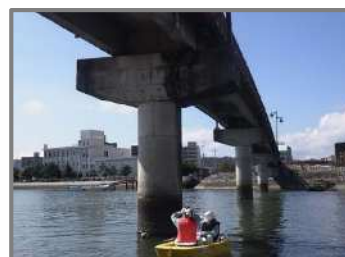
写真 3-8 ボートによる点検状況
