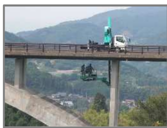
写真 3-4 橋梁点検車による点検状況
