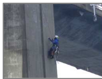
写真 3-5 特殊高所技術による点検状況
