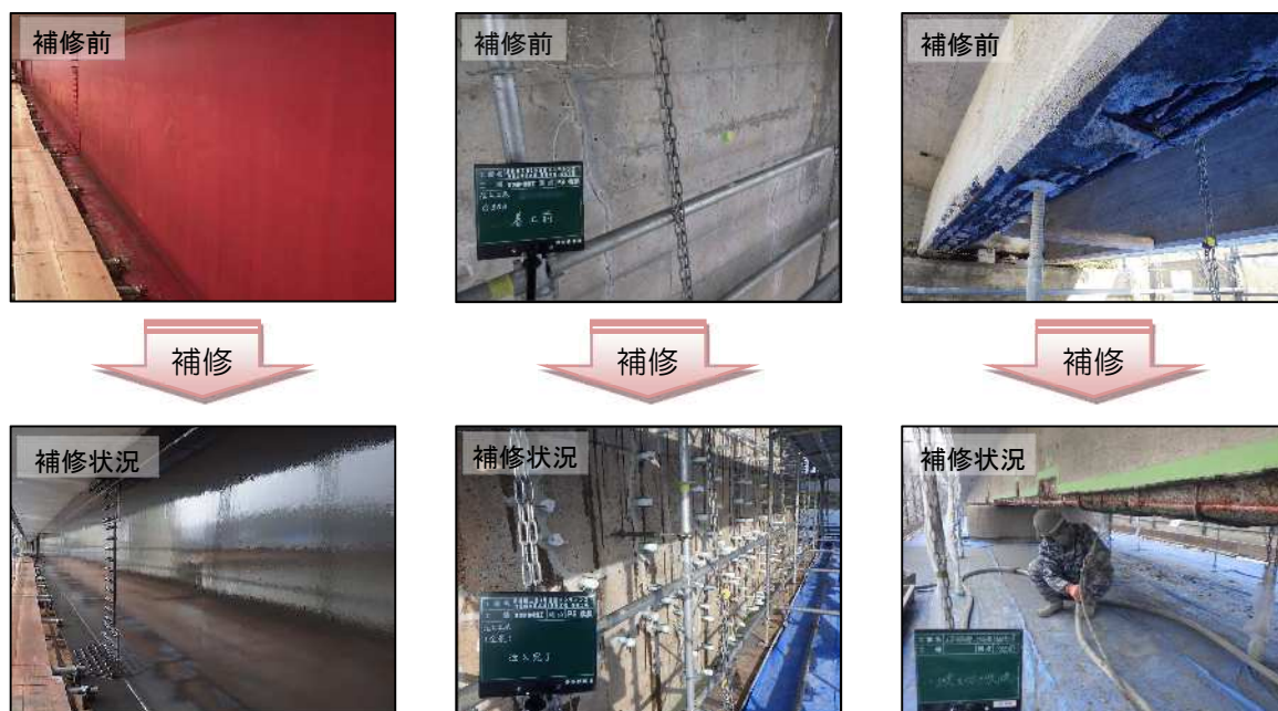
写真 3-9 塗替塗装工
