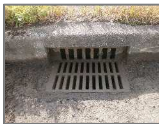
写真 3-3 排水柵の清掃後
