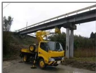
写真 3-6 高所作業車による点検状況
