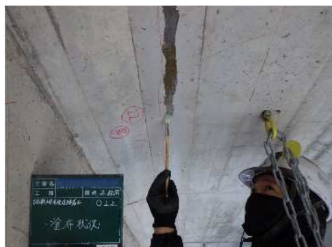
写真 5-1 新技術の採用例（浸透性エポキシ樹脂塗布：工期の短縮等作業性の向上）
