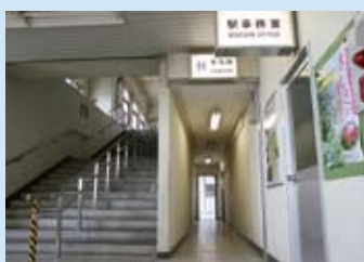
▲東唐津駅の構内(工事前)
