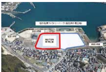
▲平成29年5月操業に向けて、ポラテック西日本(株)の第1期工場が建設される
