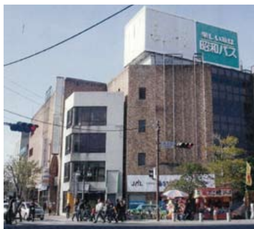
取り壊される前のバスセンター
