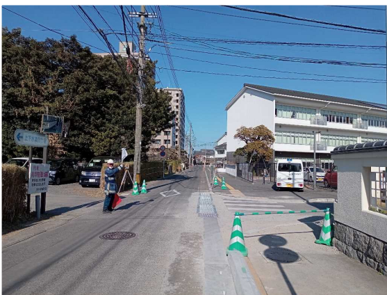
西ノ門線（唐津） 側溝改良 L=32m 事業費 10,250千円
