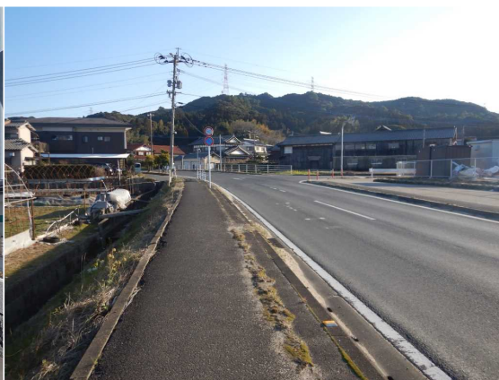
千々賀石志線（唐津） 歩道改良舗装 L=30m 事業費 9,482千円
