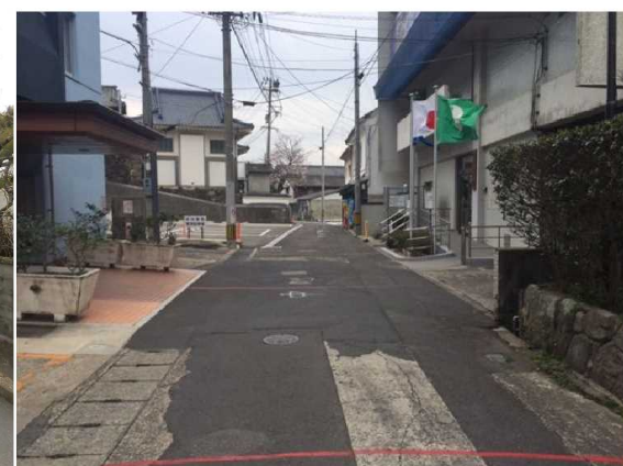
呼子町内線（呼子） 道路改良舗装 L=40m 事業費 10,410千円
