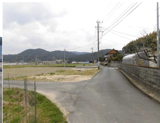
大野夕日線（相知） 道路改良舗装 L=60m 事業費 10,410千円
