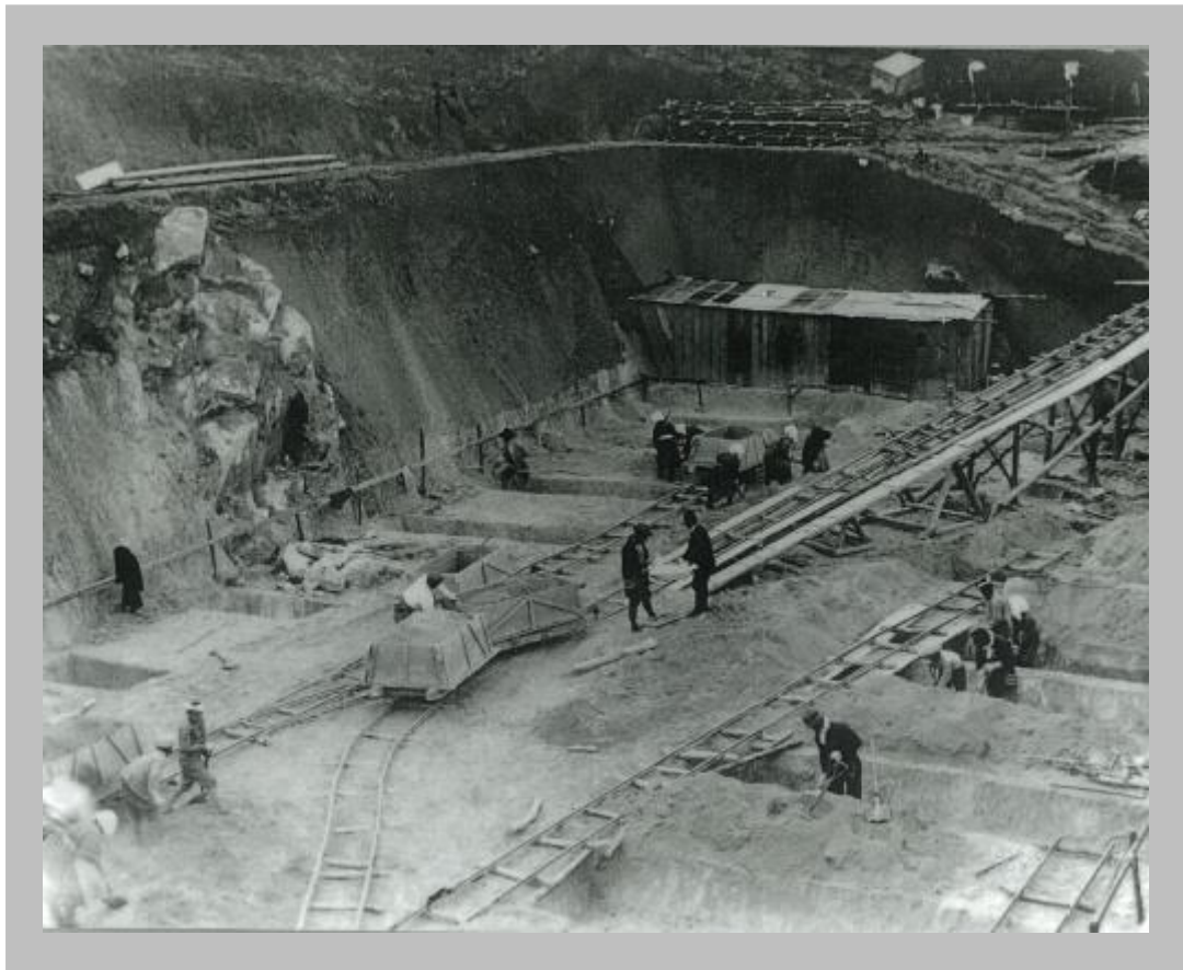
昭和10年 配水池掘削工事
