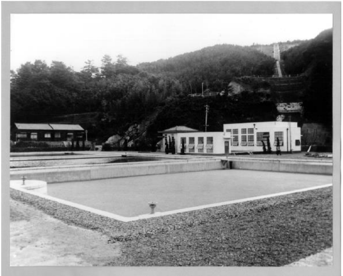
昭和 12 年建設当時の鬼塚浄水場（現在の和多田浄水場）
