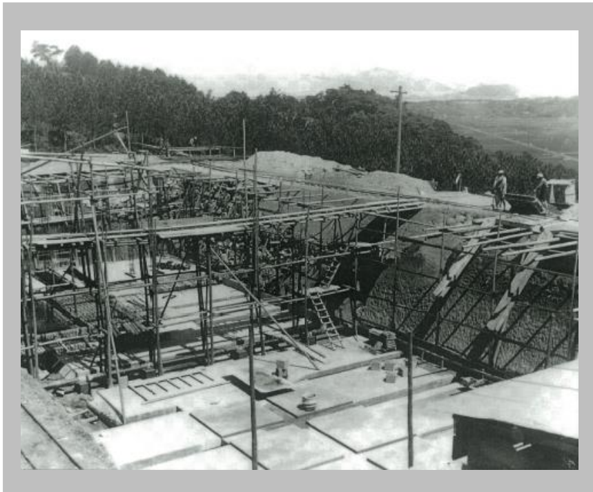
配水池築造工事
